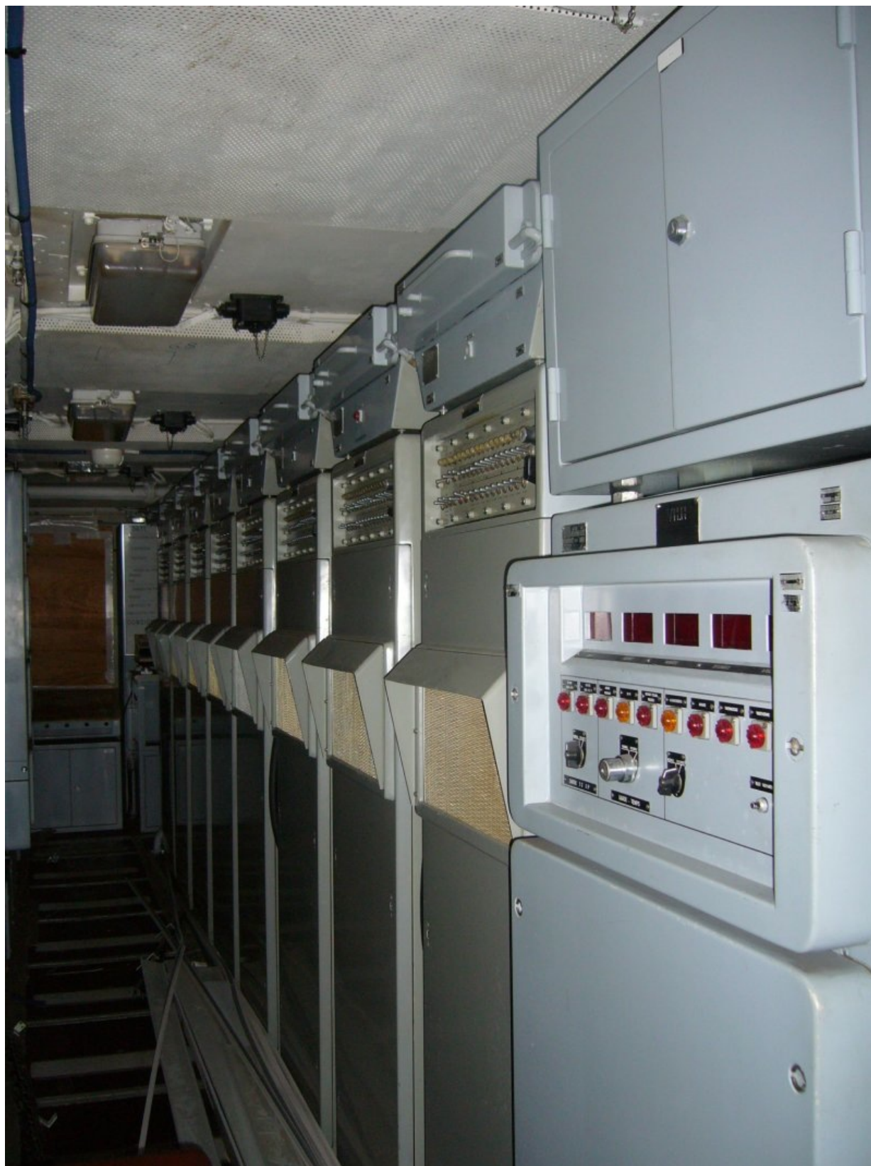
Les 8 armoires Marine (armoires Chaix) contenant les CAE133 et CAE 174.
